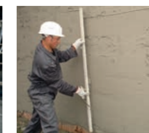
Aperto e nivelamento
